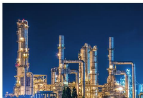
Doc. 3 La séparation des hydrocarbures est réalisée dans ce type de tour (à gauche) : après chauffage à 400 °C, on soutire les composés les plus légers en haut et les plus lourds en bas de la tour.
